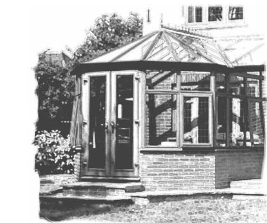
Véranda aux murs et toit vitrés, à éviter au sud en raison de l'effet de serre.
