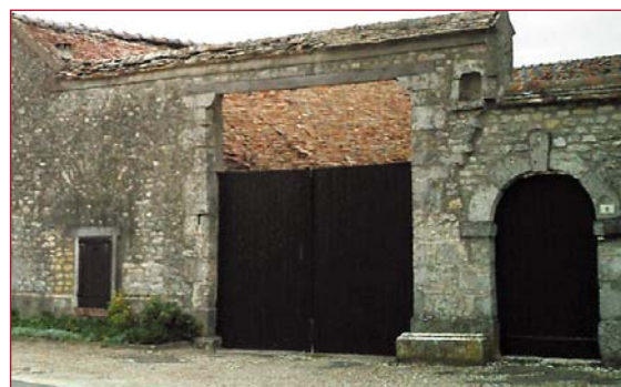
Porche en maçonnerie à Levesville-la-Chenard avec un linteau droit et une porte piétonne accolée.
