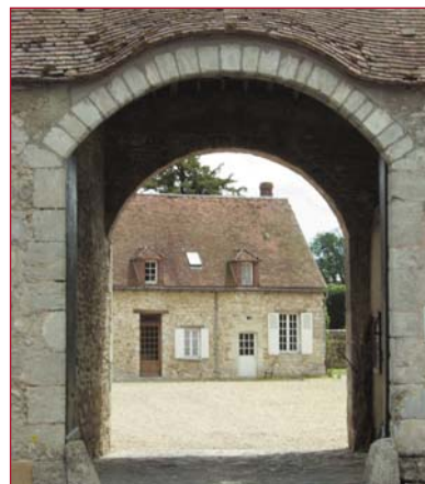
Mur de clôture en maçonnerie de moellons* calcaires hourdée* à la chaux* et chaperon* maçonné à Saint-Léger-des-Aubées.
