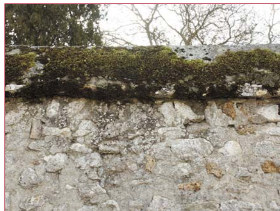
Mur de clôture en maçonnerie de moellons* calcaires hourdée* à la chaux* et chaperon* maçonné à Saint-Léger-des-Aubées.
