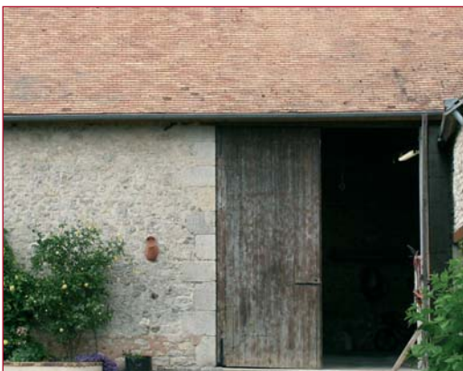
Moellons* calcaires à "pierre vue" et pierre calcaire taillée en encadrement de la baie.
