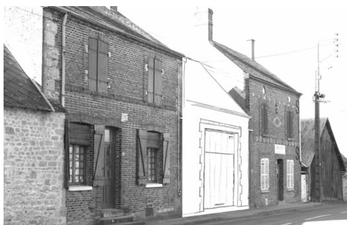
Après : mise en valeur de la baie
