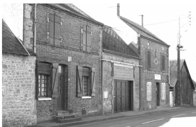
Avant : baie dénaturée (partiellement remplie en parpaings).
