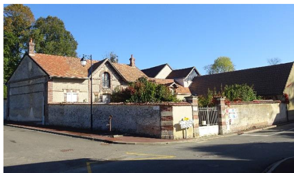
Maison au n°14 rue de la Rémarde
