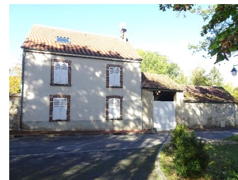
Ferme, au n°9 rue du Pont
