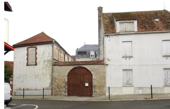
Place du Marché n°1 (côté rue du Marché)
