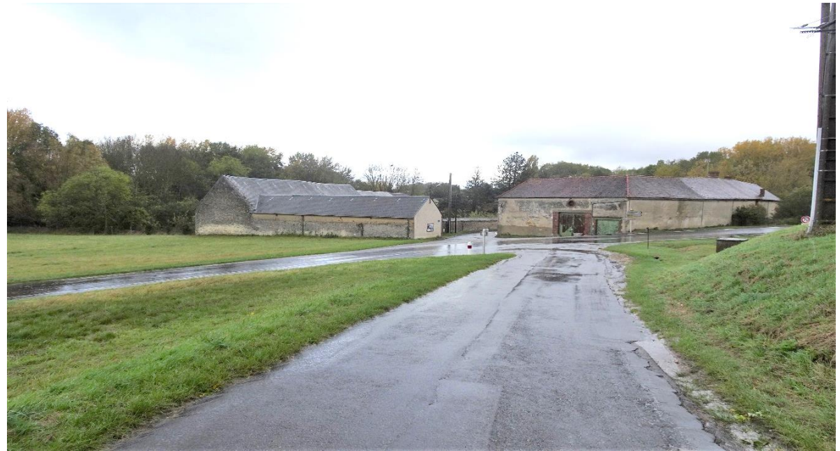
Moulin et ferme de Montaigu, vue générale sud
