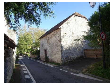
Grange-remise d'origine du XVIII e siècle, n°8 rue du Pont
