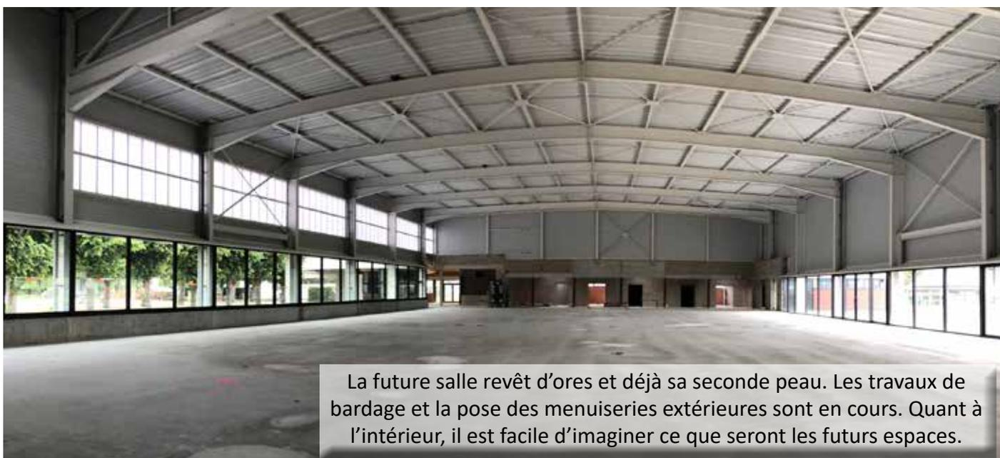
La future salle revêt d'ores et déjà sa seconde peau. Les travaux de bardage et la pose des menuiseries extérieures sont en cours. Quant à l'intérieur, il est facile d'imaginer ce que seront les futurs espaces.
