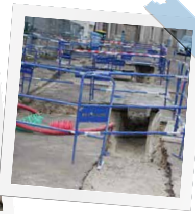
Enfouissement des réseaux, Grande rue d'Equillemont
